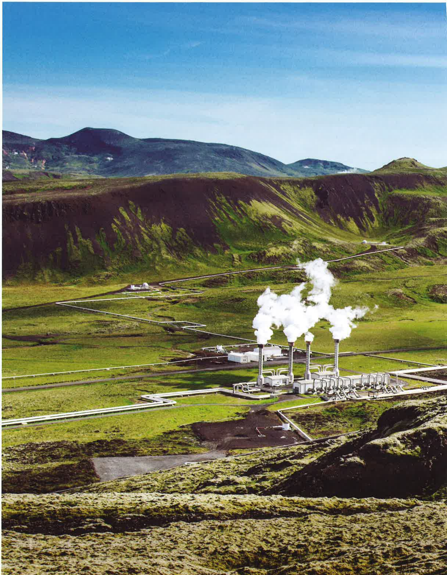
De geothermiecentrale Nesjavellir in het desolate IJslandse landschap. Foto Bartek Wrzesniowski / Alamy Stock Photo
